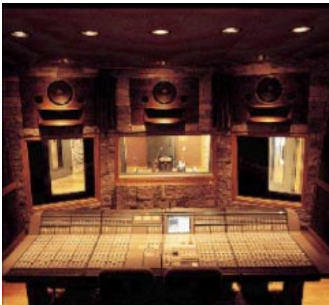
Bulldog Studio (Franklin, Tennessee, 1998) Kinoshita/Hidleyによって世界ではじめて作られたDVDミュージックスタジオ。モニターはフロント、リアともにRM-5BCで、従来の映画用サラウンドシステムとはまったく異なるコンセプトをもつ。5本のモニタースピーカーは注意深く同心円上にレイアウトされている。メインモニターだけで、24Hz 20kHzを整った位相で再生する。サブウーファーはフォーマット対応のために設置しているが、本来必要としない。
