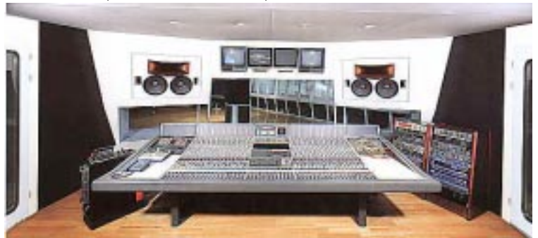
BOP STUDIO (Mabatho, South Africa 1991) 世界屈指の規模と性能を誇る。 ノイズレベルは8dB (A)以下。世界初のインフラソニック (9Hz)スタジオでもある。
